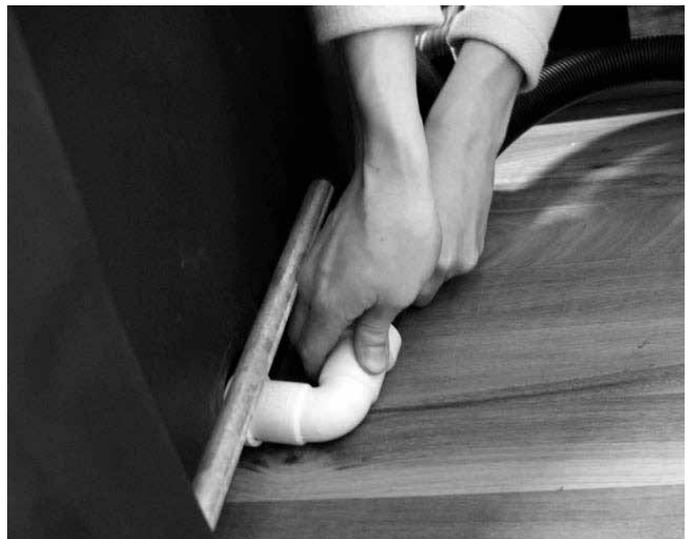
2. Abziehen des Abflussschlauches
