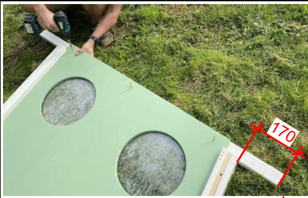
2. Dachstrebe montieren Schrauben aus Packung C: 5x55 mm
