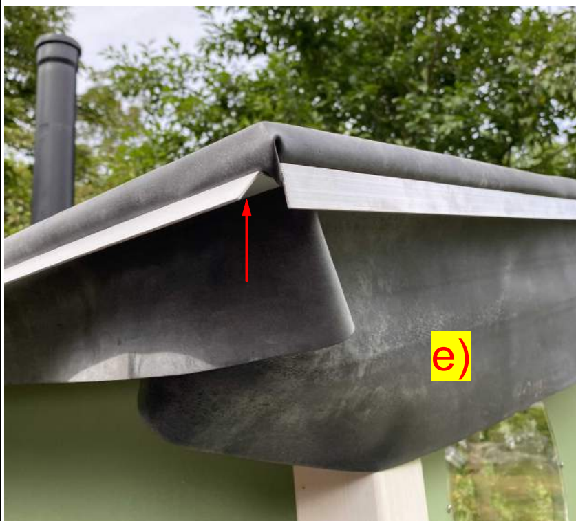
Straffziehen und festschrauben
