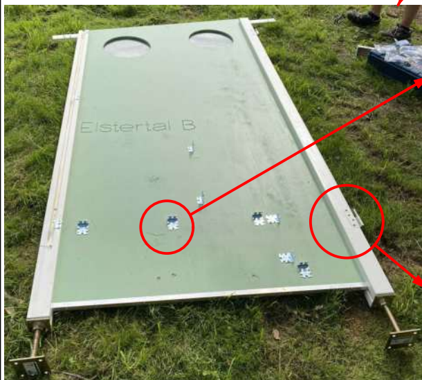
3. Eurowinkel anschrauben Schrauben aus Packung A: Euroschrauben Türbänder montieren (Seite rechts + Türe) Schrauben aus Packung E: 4,5x35 mm
