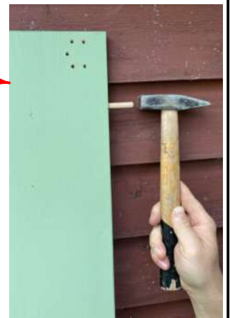
5. Holzdübel in Rückwand einschlagen (Packung D)
