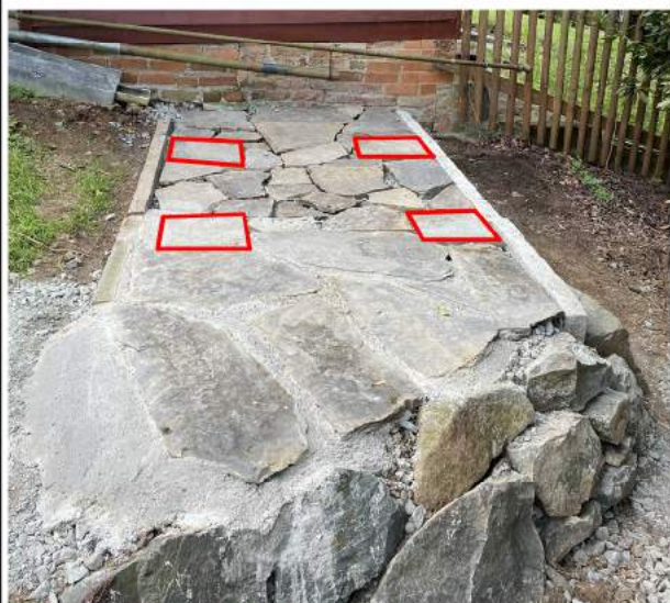
Beispiel Punktfundamente
