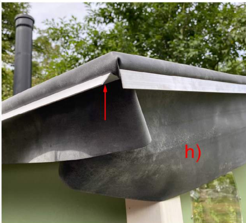
Straffziehen und festschrauben
