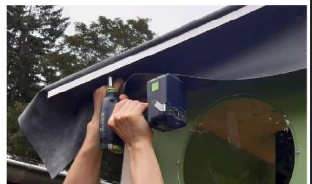
Straffziehen und festschrauben
